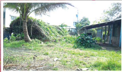
風災造成石龜溪教會受損照片
